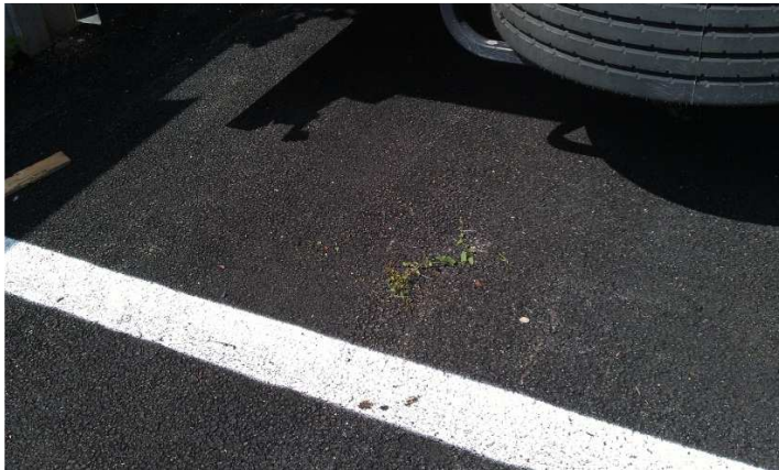
Photo 31 Remontées de terre Pousse de végétation
